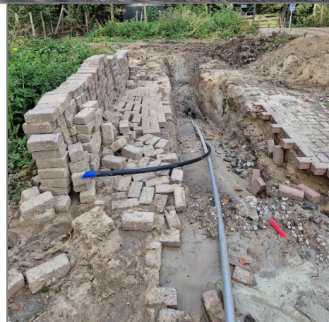
Boren van een waterstofpijplijn van KWR naar JosScholman
